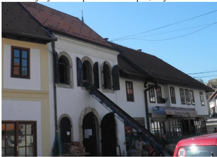
Završeni građevinski radovi na spratu i krovu zgrade uz Kahvu, prostor uvakufio Suljo Hrvic – 07.11.2013.
