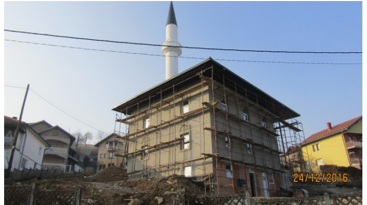
Izgradnja nove džamije u džematu Bukva – 24. 12. 2016.
